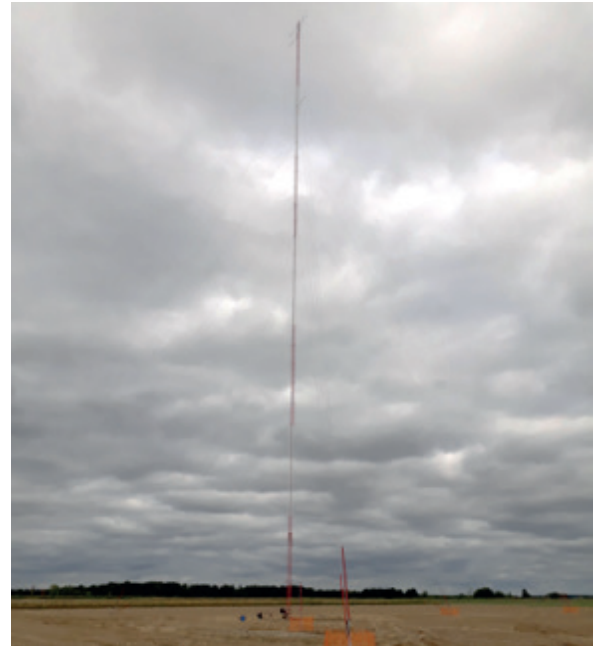
Le mât posé en août 2019
